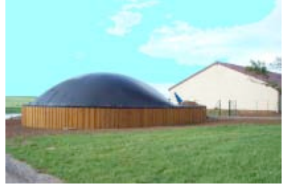
Exemple de stockage de gaz intégré au digesteur. Photo AGRIKOMP
