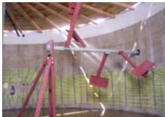
Mélangeur à grandes pales sur axe horizontal. Photo Agrikomp
