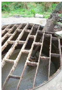
Préfosse d'alimentation avec brassage. Photo SOLAGRO
