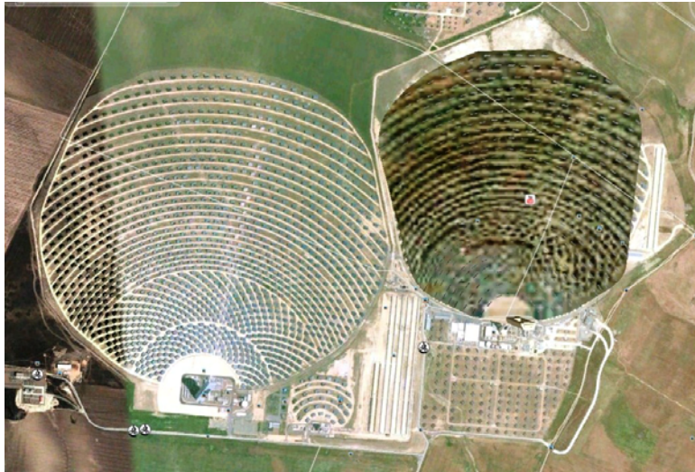
Vue aérienne Google Earth de la centrale solaire espagnole de Sanlucar
