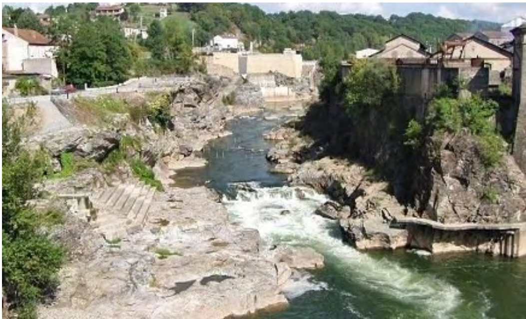
Usine hydroélectrique du Saut-de-Sabo sur le Tarn.
