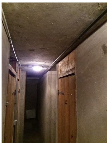
Plancher du sous-sol
