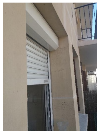
Fenêtre double vitrage équipée de volet roulant
