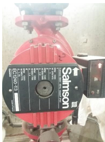
Pompes de circulation du chauffage
