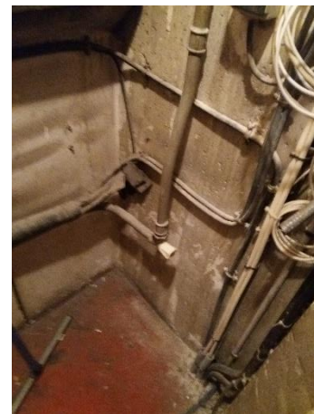
Réseau de chauffage vertical en gaine technique palières
