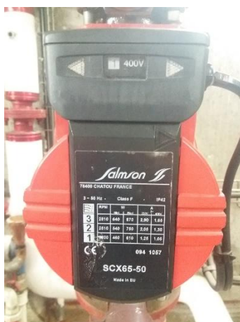
Pompes de circulation du chauffage
