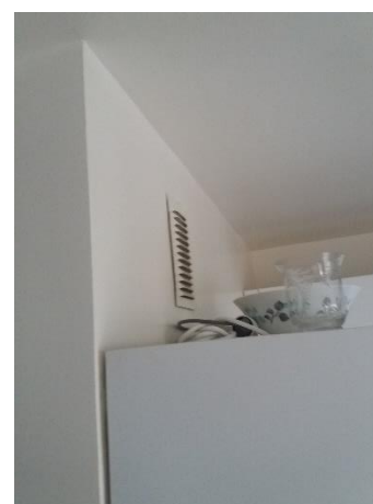
Aérations hautes de cuisine, en conduit
