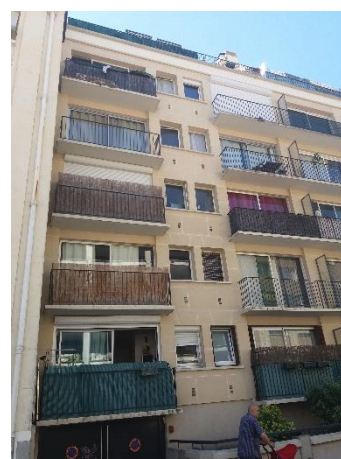
Mur de façade côté rue
