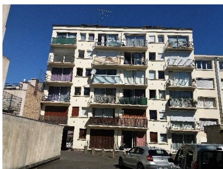
Mur de façade côté cour
