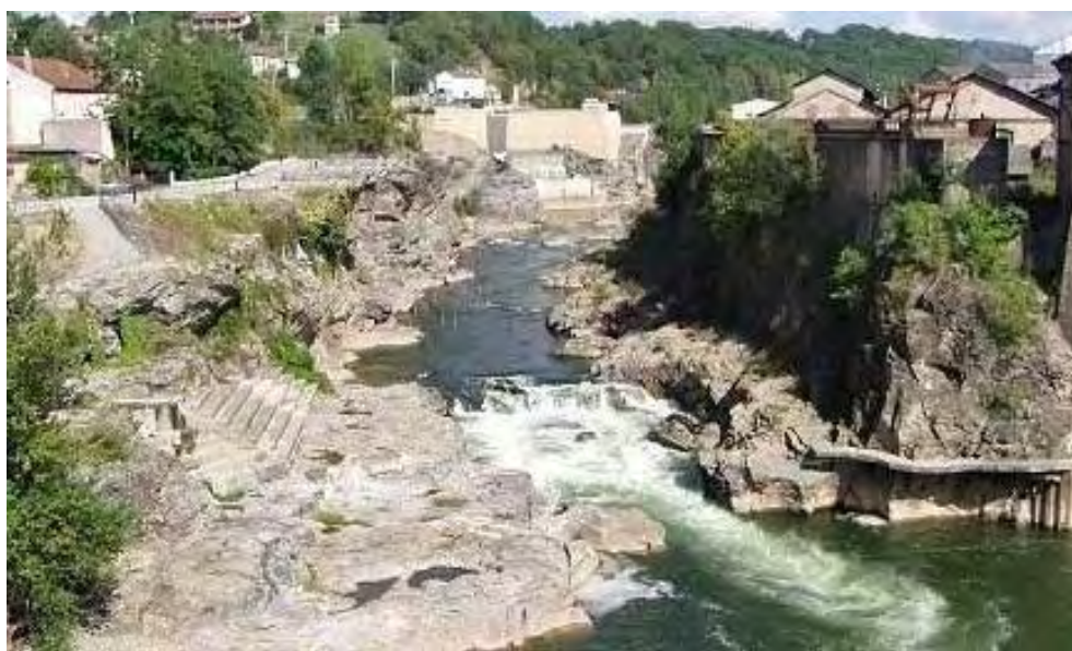
Usine hydroélectrique du Saut de Sabo sur le Tarn.
